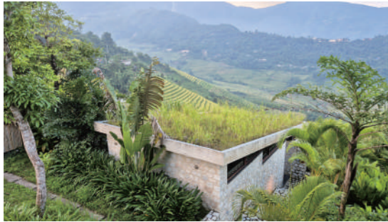
풀빌라 옥상 복사열을 저감하는 초본 식재와 지하층 중수도 물순환 시스템
